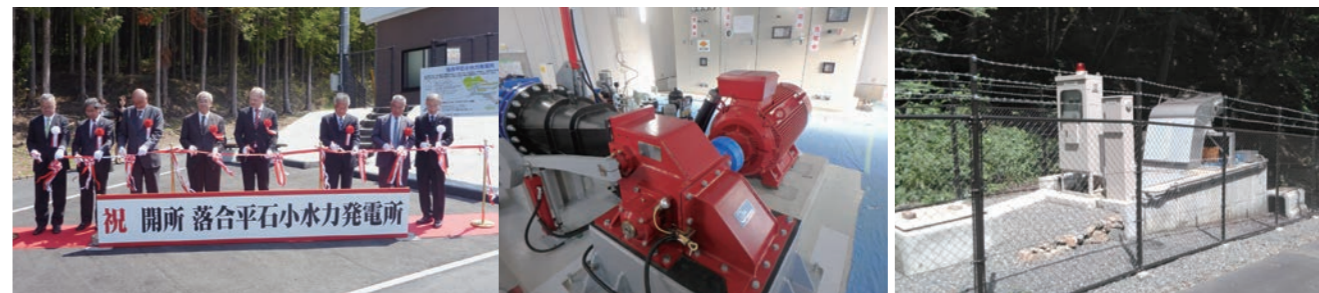
中津川小水力発電事業
