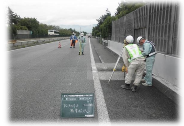
現地測量状況
