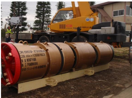
推進工法のマシーン
