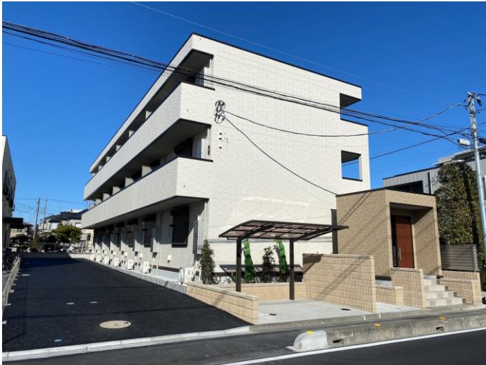
社員寮、建替完了 2022年2月完成
