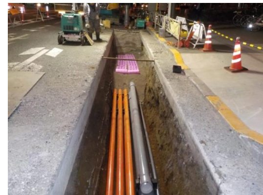
電線管・通信管の布設状況
