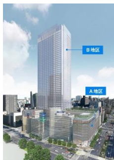
東京駅北口開発(鹿島建設)
